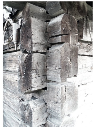
Abb.06 & 07: Holzständerbau bzw. Holzblockbauecke
