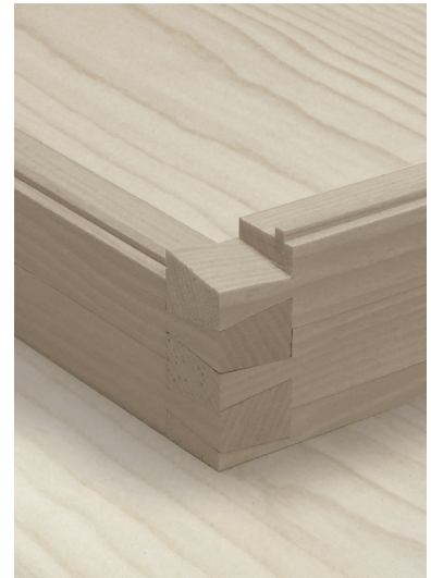
Abb.10: Konstruktionsmodell Fügung mittels „Tiroler Schloss“
