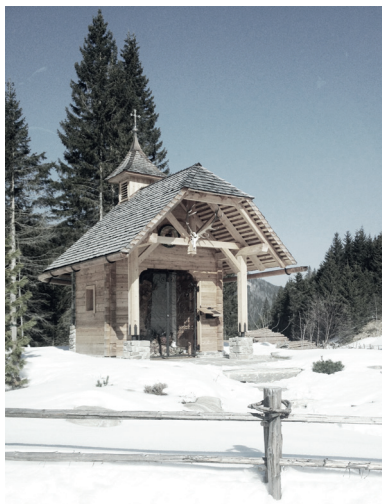
Abb.17: Traditionelles Schindeldach auf einer Kapelle
